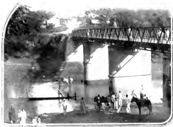
Rio de Janeiro Bridge, Matto Grosso.
