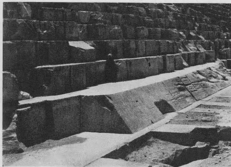
Abb. 1. Pflaster und unterste Bekleidungsschicht auf der Nordseite, von NO gesehen.
