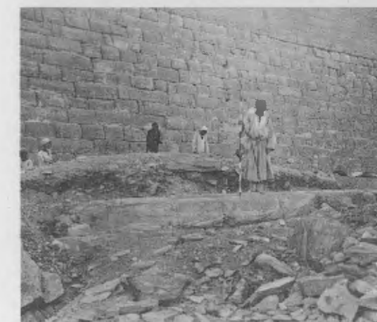
An der O-Seite E 2,10 mit dem unteren Teil des Anschlusses einer Stufe
