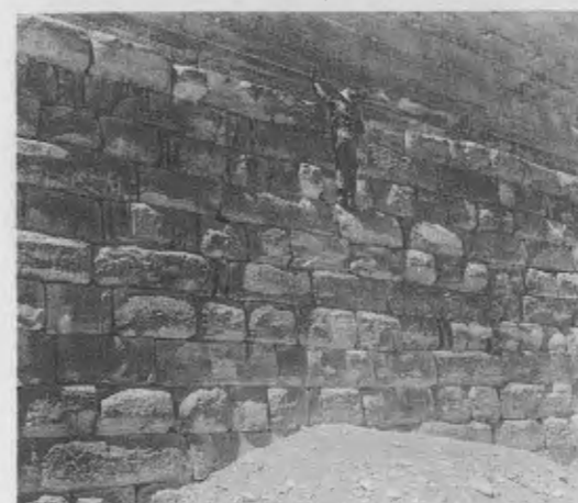
An der N-Seite Anschluß der Deckplatten einer Stufe
